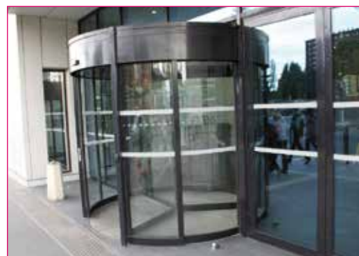
Il est recommandé de disposer à l'intérieur deux bandes horizontales de 5 cm de large situées respectivement à 1,10 m et 1,60 m de hauteur.
